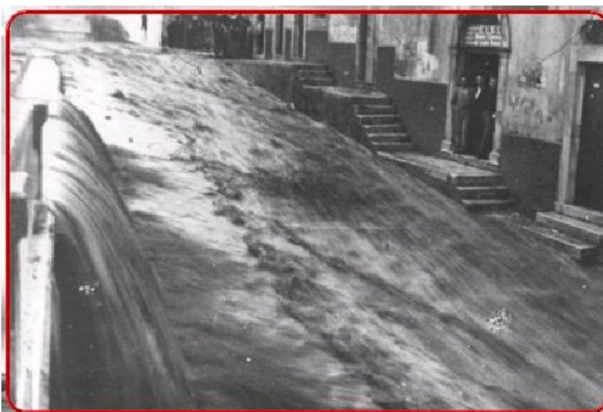
Fig. 3 - Torrente Cucca -via Papa Giovanni XXIII° (alluvione del 1955) - foto storica
